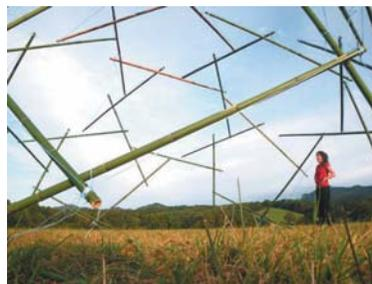
Cette structure monumentale est étudiée en deux versions 12 et 15m de diamètre. Les 40 pièces de la structure sont fabriquées selon le schéma précédent. La structure est ensuite facilement installable et démontable sur n'importe quelle surface à l'aide d'un chargeur de location (manuscopic).
