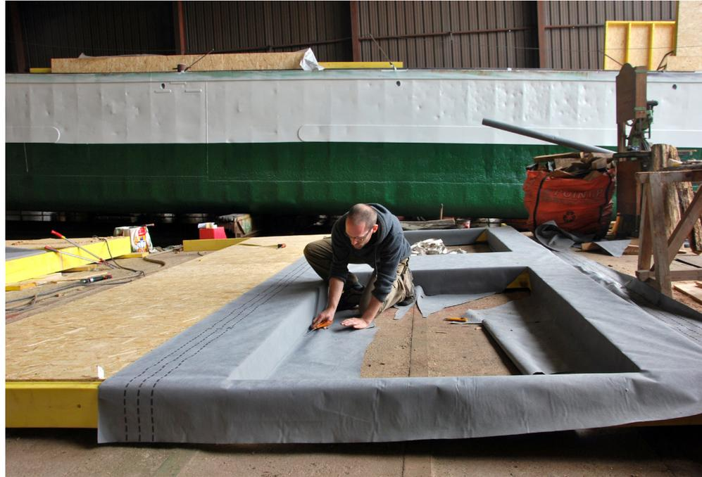
les modules sont fabriqués sur le marbre puis grutés dans le bateau
